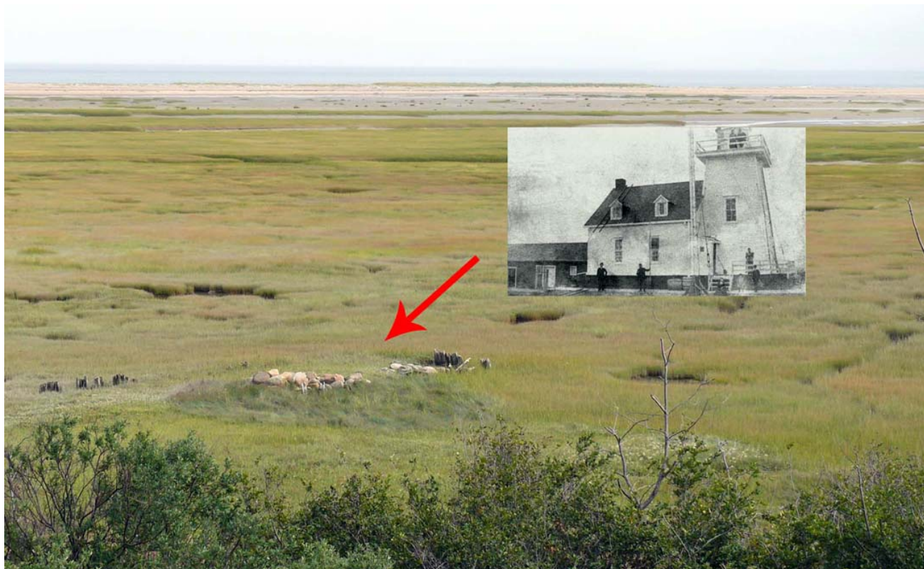
Le premier phare de Portneuf et les vestiges. Photo : Jean Cloutier
