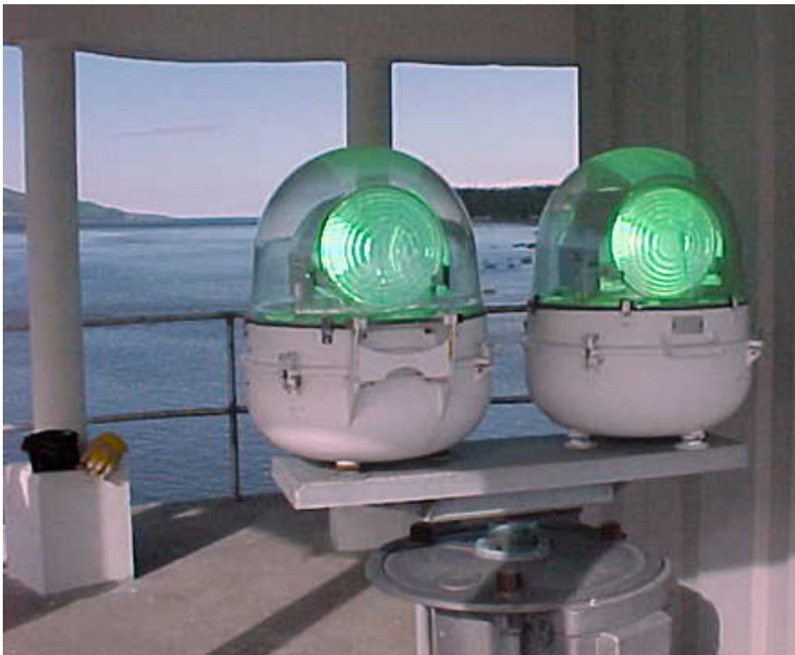
L'installation des deux DCB-10 dans la lanterne du pilier de Prairie. Photo : Maryse Vaillancourt, Technicienne, Entretien Aides à la Navigation
