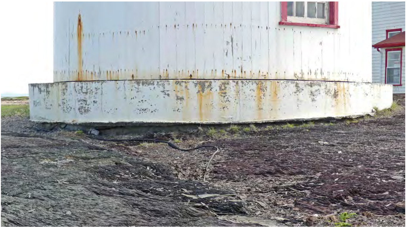
Déchaussement de la base du phare de l'Île Verte. (photo: J. Cloutier)
