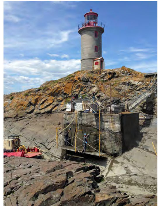
4: Le grillage et soufflage du béton.
