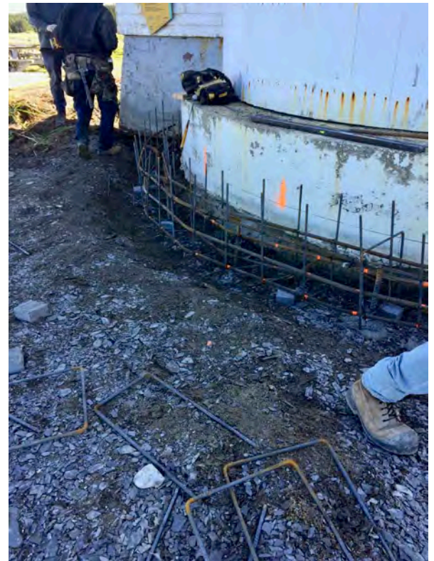
Travaux de consolidation. (Photo : L. Newbury)
