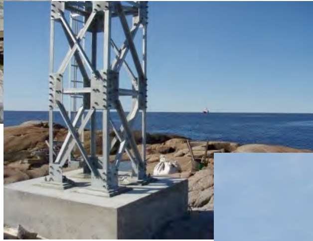
Installation d'une nouvelle base de béton et de la nouvelle tour à claire-voie.
