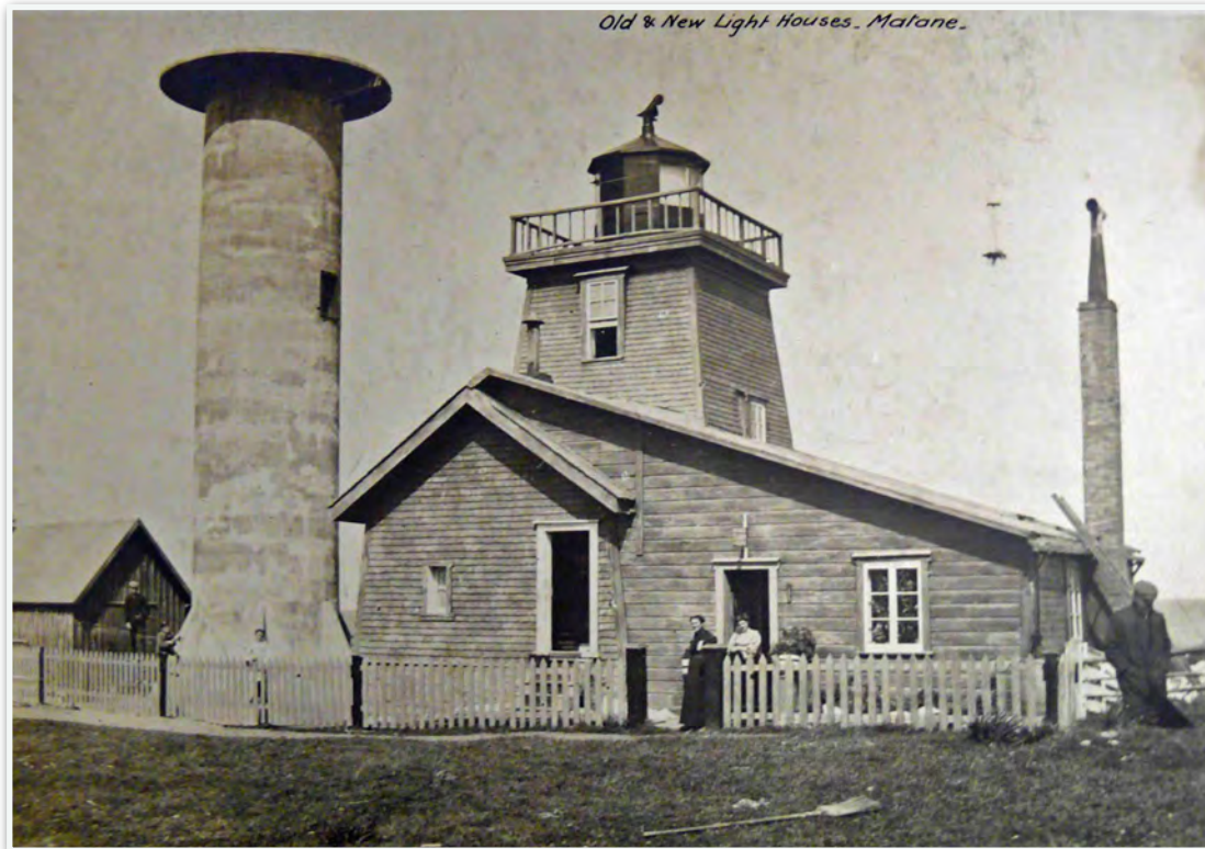
Vieux phare-maison de Matane lors de la construction de la nouvelle tour en béton armé. Nous remarquons très bien le petit toit de la maison qui a la même largeur que le phare et l'ajout vers la droite jusqu'à la haute cheminée. Photo : Archives Nationales du Canada
