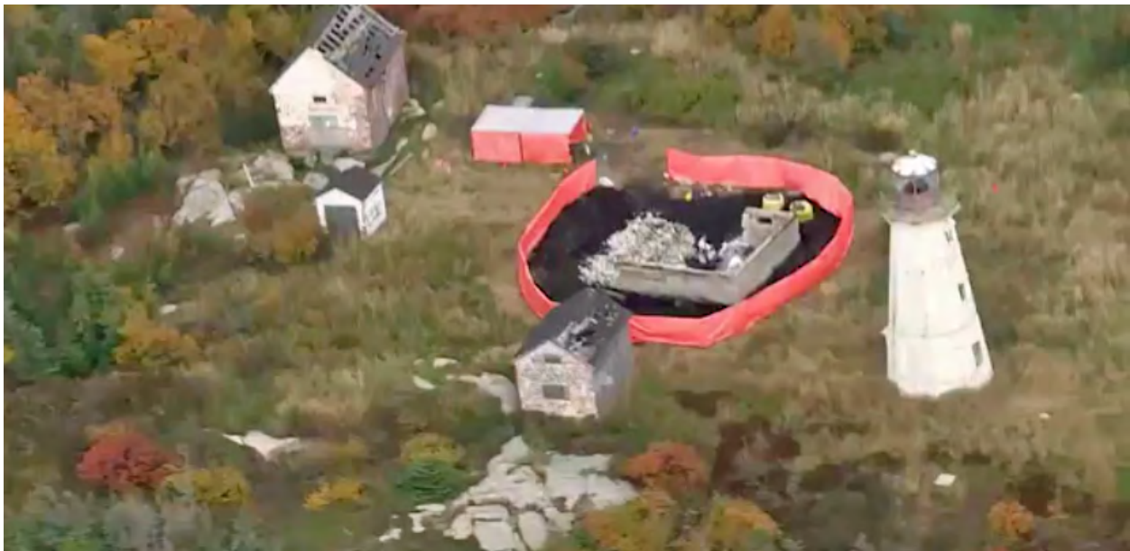
Travaux à l'île du Corossol. Source : Le Journal de Québec 20 septembre 2020
