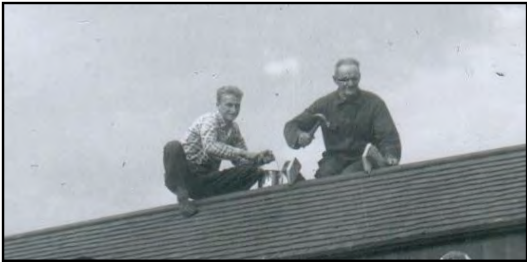
L'assistant Roch Michaud et le gardien Freddy Lindsay réparent la toiture du pont couvert à l'est du phare. Coll: Jocelyn Lindsay
