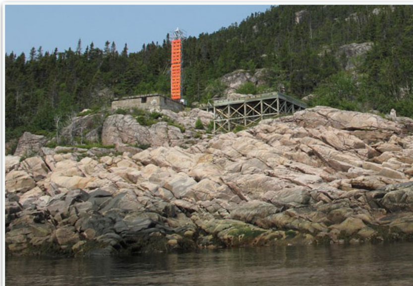
Expédition entreprise par M. Napoléon Martin à l'été 2013, sur la Pointe Saint-Pancrace à partir de la mer. On y voit la tour installée, dans les années 1970, sur les anciennes fondations. Fonds Napoléon Martin, Société historique de la Côte-Nord.
