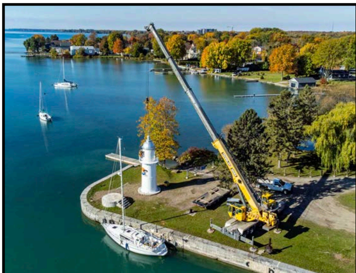
Réinstallation du phare à côté de sa position d'origine. Source : Skye Média
