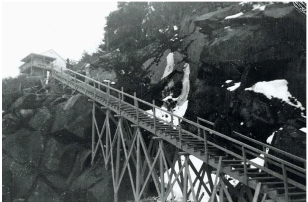
Figure 12 Vue de l'escalier menant de la voie ferrée vers la deuxième maison du gardien (collection Michel Bouchard)
