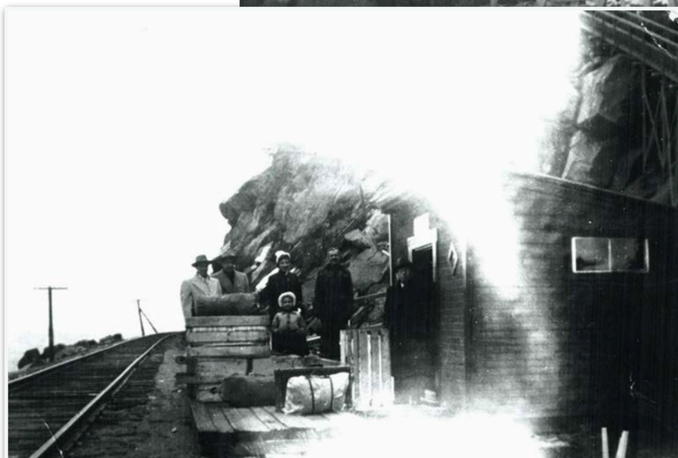
Figure 13 Vue de la gare-abri du cap Brûlé (collection Michel Bouchard)
