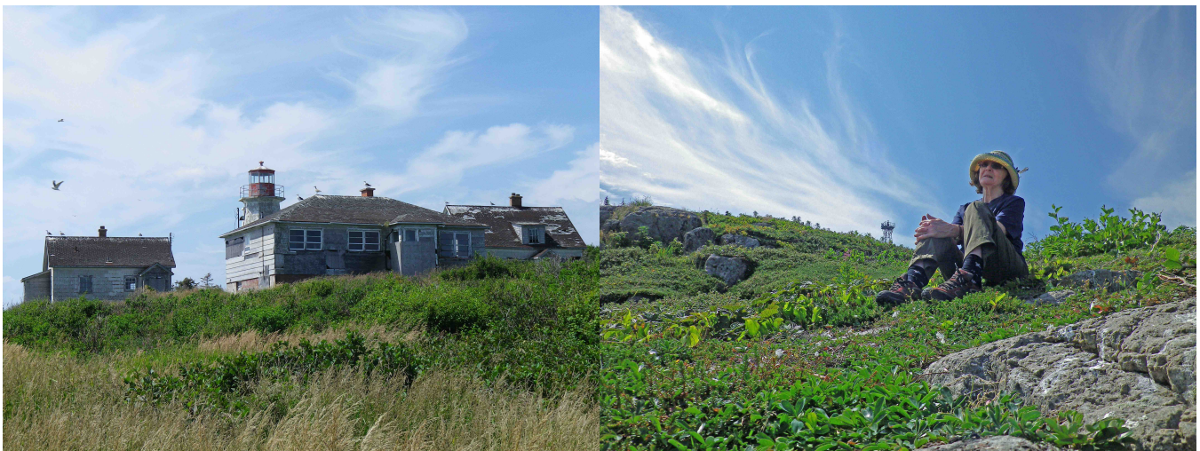
L'état délabré des lieux suite à l'automatisation et le départ de son gardien. Antoinette Gallienne garde quand même de bons souvenirs de ses 32 années sur ce site. Photos: 2014 par Mario Mercier
