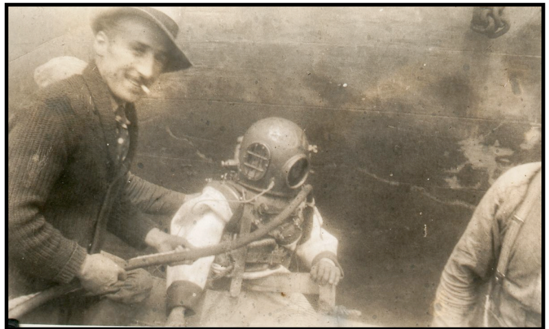
Un scaphandrier vint inspecter les dommages le 18 août pour voir si des réparations étaient possibles en colmatant le trou. Coll: Jocelyn Lindsay
