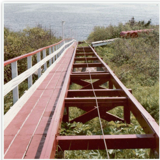
Le système de remonte-charge à l'île du Corossol. Photos : Mario Mercier
