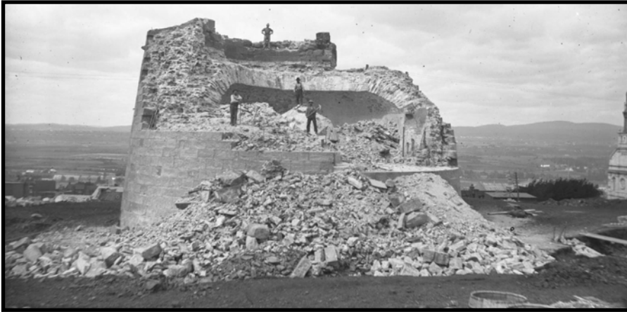
Démolition de la tour No.2 à Québec en août 1904, nous montrant l'épaisseur des murs. Coll: Archives Ville de Québec
