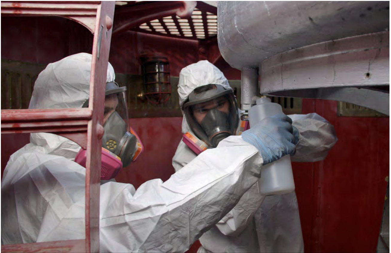
Bassin de mercure sous la lentille. Coll: Paul Gendron / Bain de mercure descendu comme un boulon. Coll: Stéphanie Pépin / Ouverture du bouchon sous le bassin pour la vidange du mercure. Coll: John Price Techniciens procédant à l'enlèvement, drainage du bain de mercure. Coll: John Price
