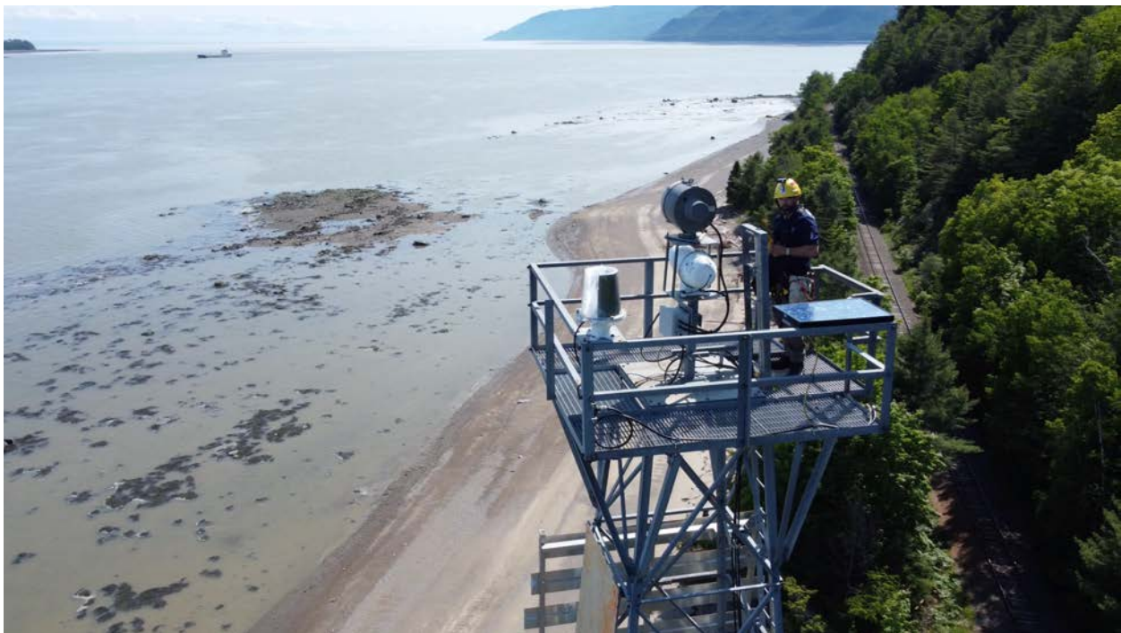
Technicien dans le haut d'un feu d'alignement du Cap Corbeau dans la région de l'île aux Coudres. Collection Garde côtière canadienne
