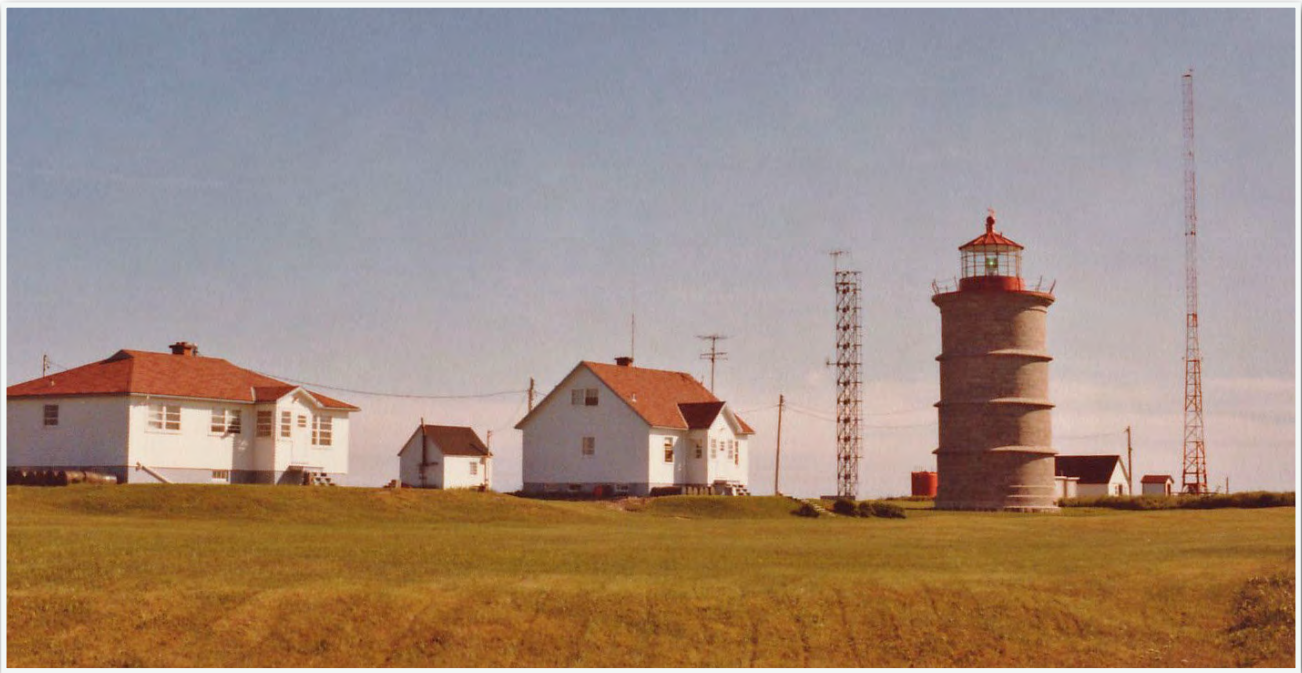
Maisons construites vers 1960, antenne radio et la grande antenne du radiophare. Photo : Mario Mercier
