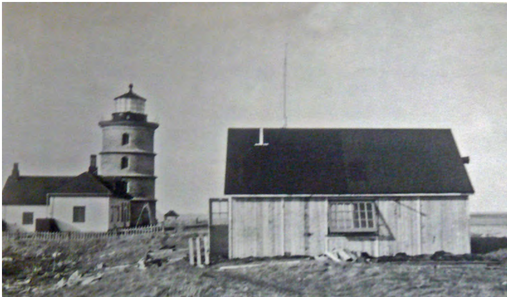
Remplacement de l'abri du signal de brume en 1945. Archives nationales du Canada
