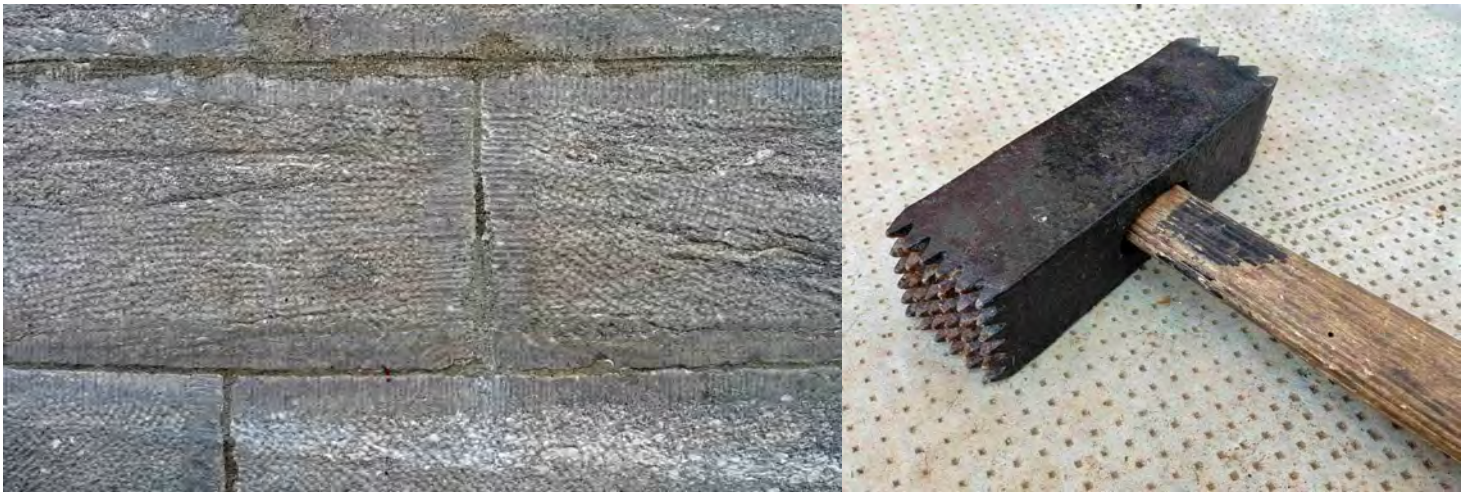
Le mur du phare de l'île Rouge avec ses pierres bouchardées et marteau à boucharder. Photo: J. Cloutier
